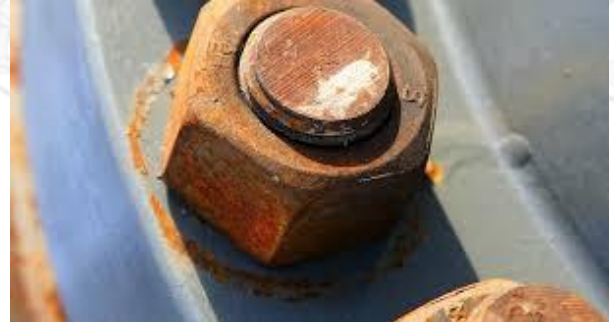
เลือกใช้การเชื่อมแทนการใช้หมุดจากโลหะต่างชนิดที่จะเกิดสนิมได้ง่ายกว่า
