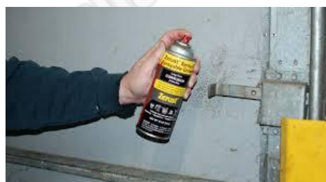
การพ่นเคลือบผิวโลหะด้วยสี สเปรย์ หรือน้ำมันกันสนิม
